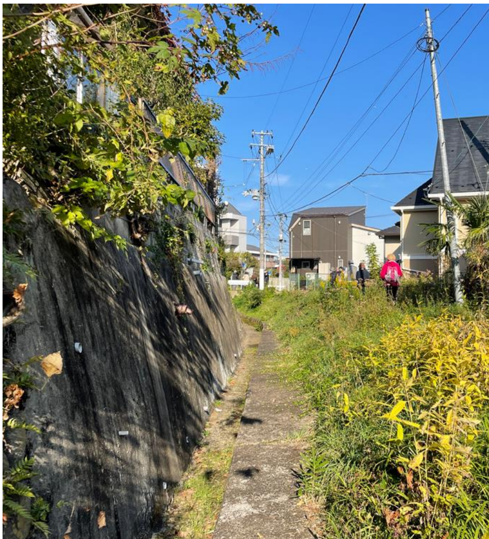
八幡町付近の四ツ谷用水(暗渠区間)
